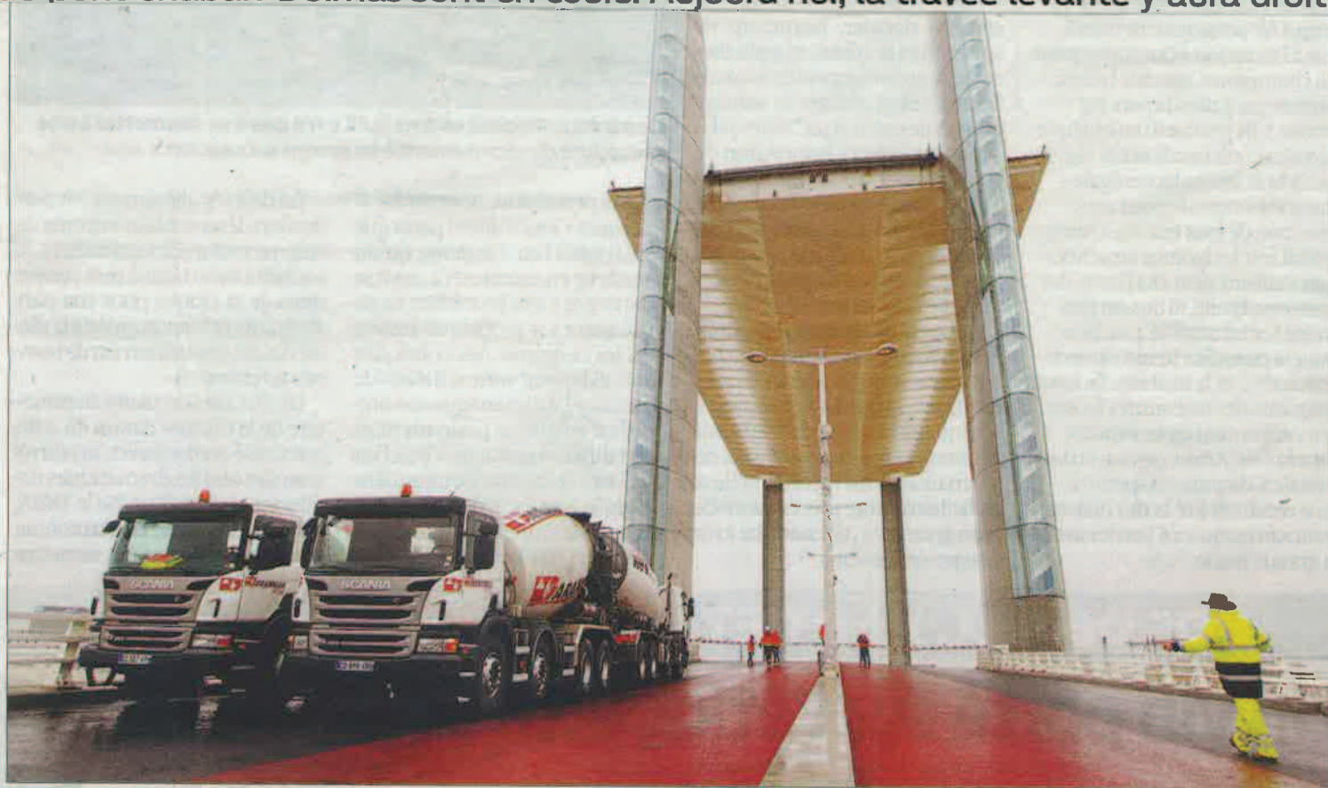
Les tests de charge vont prendre un tour plus spectaculaire aujourd'hui, sur la travée levée. PHOTO GUILLAUME BONNAUD
